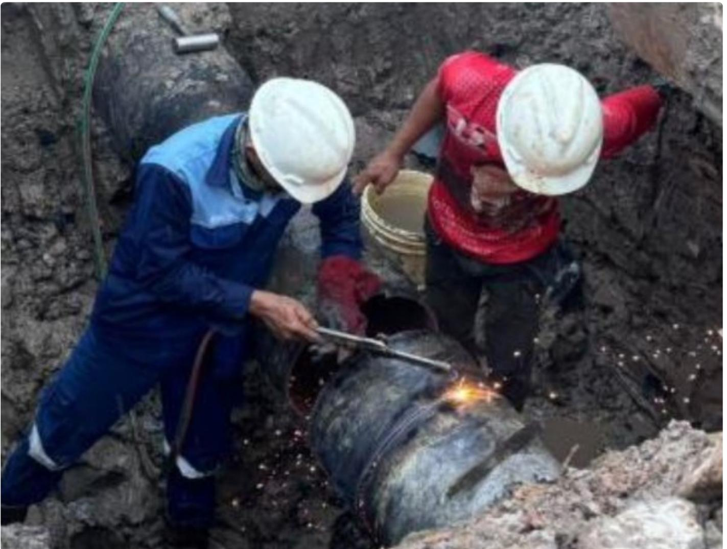
BALIKPAPAN - Pastikan pasokan air bersih ke pelanggan, PDAM Tirta Manuntung Balikpapan melakukan perbaikan pipa distribusi di depan Waroeng Steak Jalan MT Haryono - Jalan Agung Tunggal .
